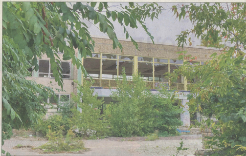
Einst ist das Objekt am Brunnenstieg als Schule genutzt worden, mittlerweile ist es baufällig. 2017 wechselte das Gebäude den Besitzer und soll nach wie vor saniert werden.
